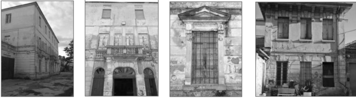
Figura 7,8,9,10 - Particolari dei prospetti del corpo di fabbrica principale
