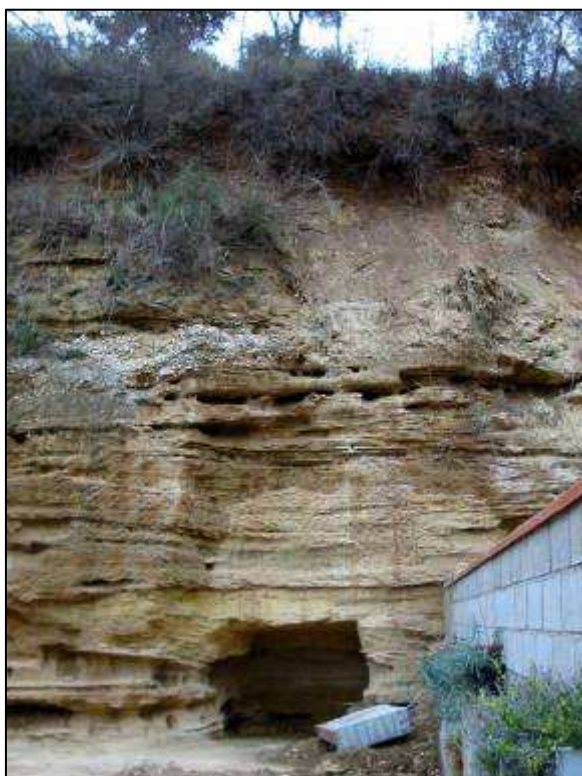
Fig.25 Materiale instabile sul ciglio della parete. Si notano le testate degli strati arenacei sporgenti e una delle grotte presenti nell'ammasso roccioso
