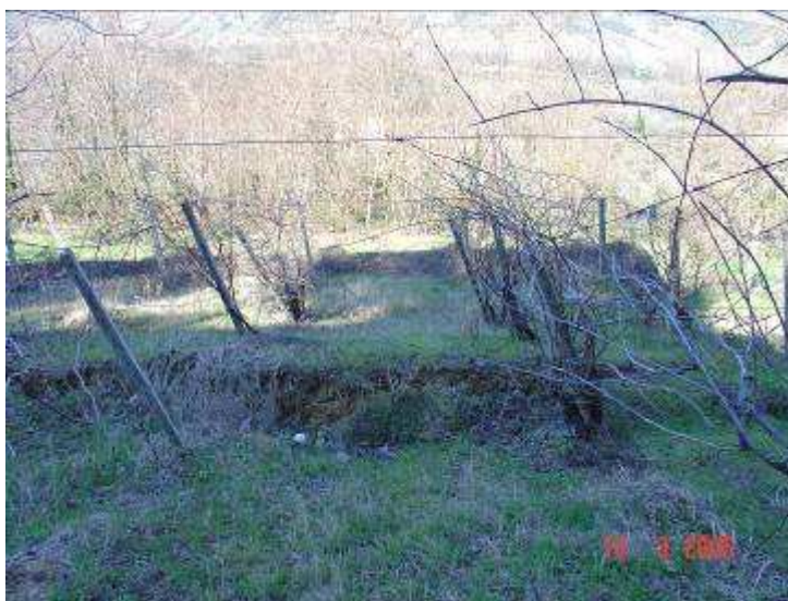
Foto n° 12 – Trincea vista dal piede della parete. La frattura aveva una lunghezza di circa 100 metri e correva parallela alla parete
