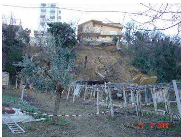
Foto n°5 – La mattina dopo il crollo del muro sottostante l'abitazione Giancristofaro, avvenuto alle ore 22,20 del 20.2.2005
