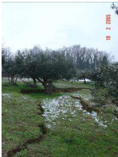
Foto n°1 – Trincea di frana a monte del fabbricato Cotellessa. Fase iniziale del movimento franoso
