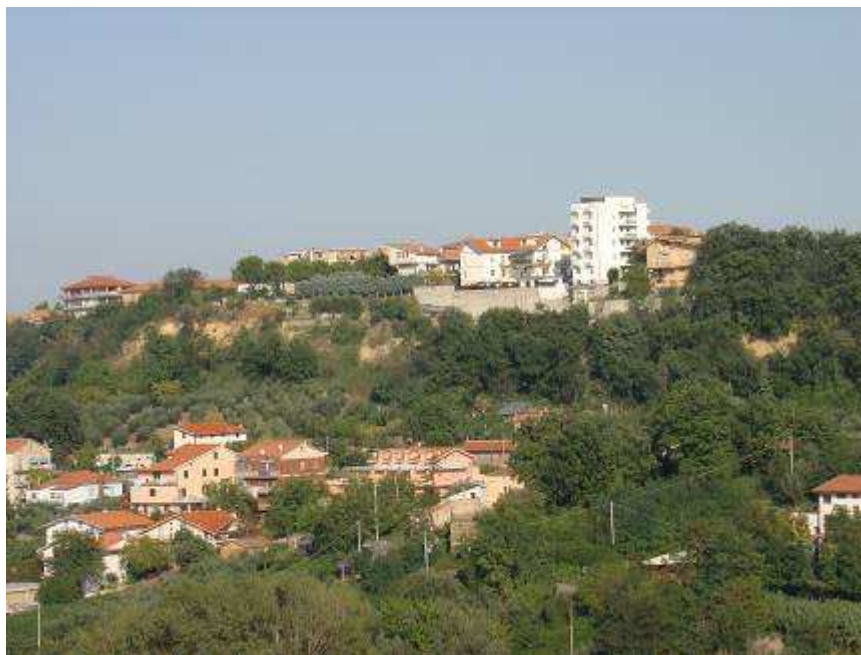
Via Belvedere con fabbricati e muro in c.a. in prossimità del ciglio di frana
