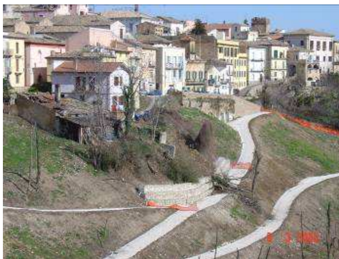
Foto n° 16 – Frana sotto Via dei Bastioni
