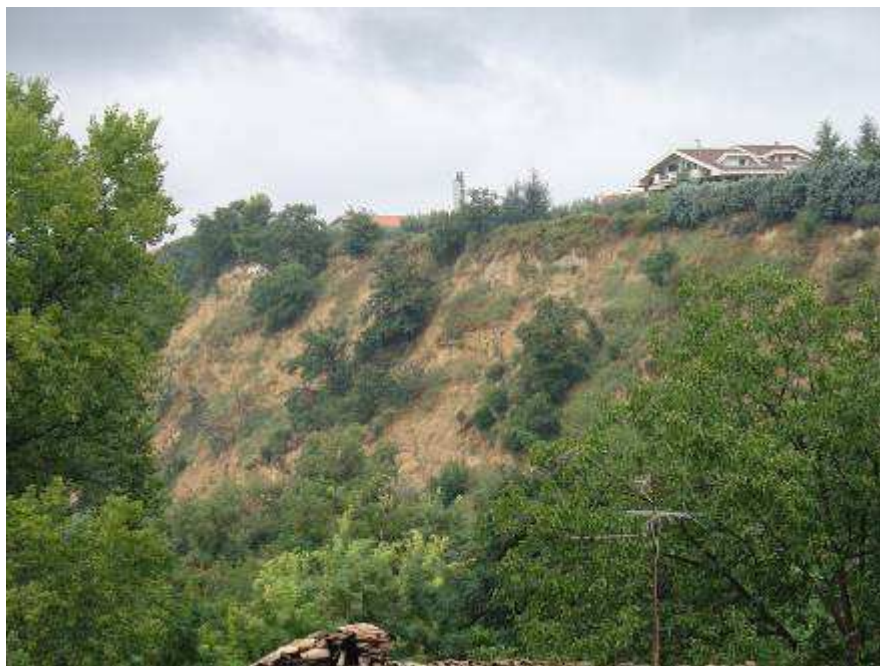
Vista prospettica (da Porta S. Biagio) del Colle delle Morelle con la vistosa falesia che deborda il lato Ovest, Nord – Ovest del versante.
