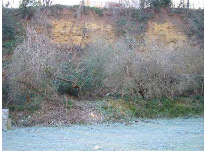
Fig. 28 Particolare di una colata, si nota lo spessore variabile del terreno di riporto.
