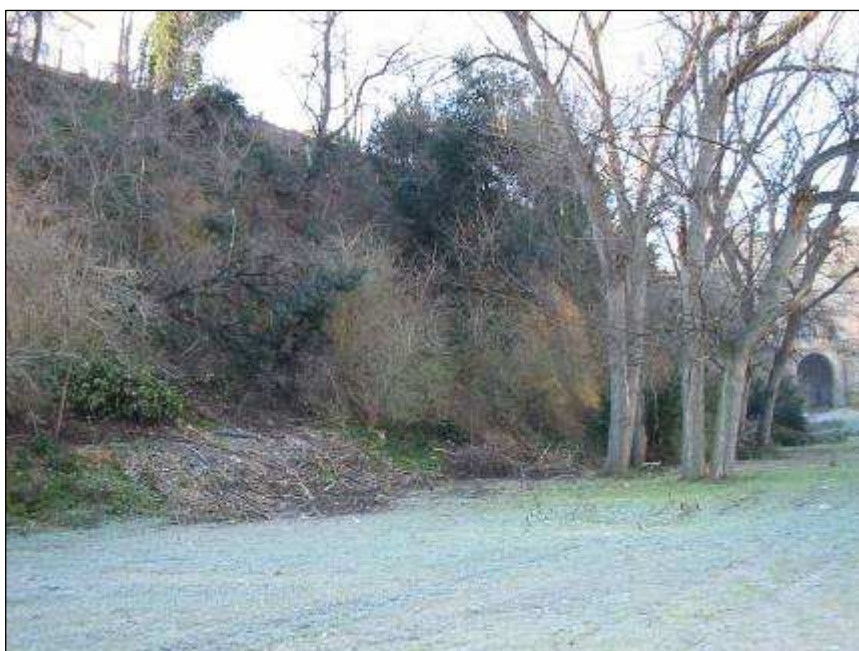
Fig. 27 Colate di terra e detrito diffuse con sradicamento della vegetazione.
