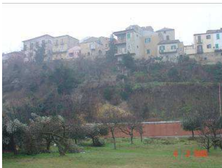
Foto n° 15 – Piccoli crolli di rocce sabbioso arenacee ( colore giallo sulla sinistra ). Sotto si nota il paramento murario che maschera delle gabbionate a presidio del piede del versante. In alto Lancianovecchia
