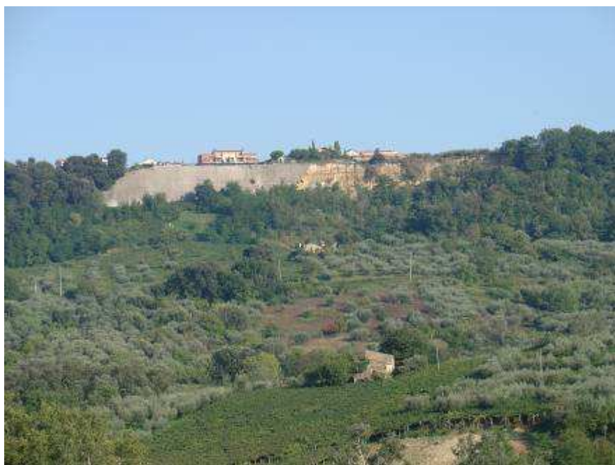
Vista prospettica della frana di S.Giusta con l'intervento del Genio Civile degli anni 80 – 90 in parte crollato ( Gunite )
