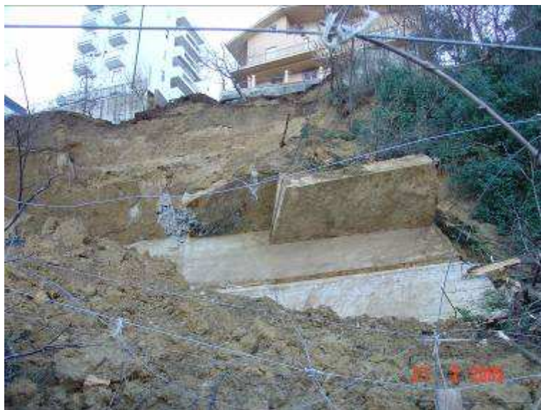
Foto n°6 – Sono evidenti le dimensioni e le caratteristiche della zattera di fondazione e dell'asta di elevazione
