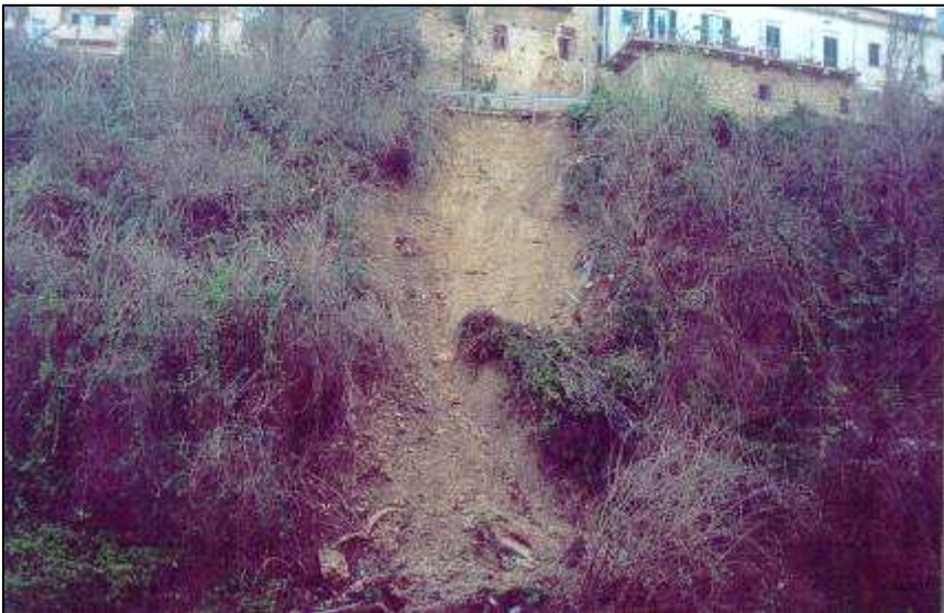
Fig. 29 Colate di terra e detrito in prossimità del ponte di Diocleziano.
