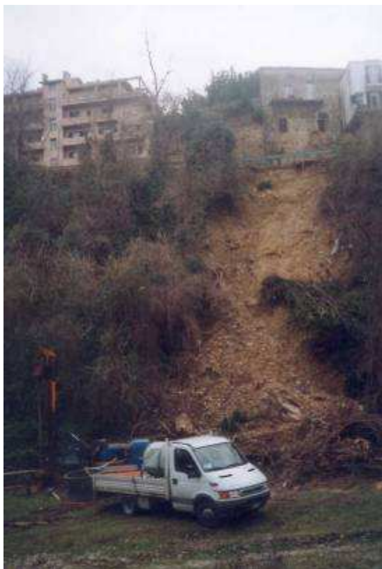
Particolare della frana di Via del Ponte con la colata di terra che interessa la sponda destra del Fosso Pietroso
